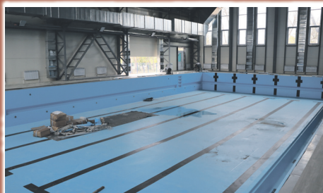
Завершается строительство бассейна стр. 6
