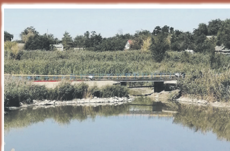
В ст. Мечётинской от- ремонтирован мост стр. 3
